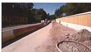
Mur de soutènement déplacé au Kronthal.
